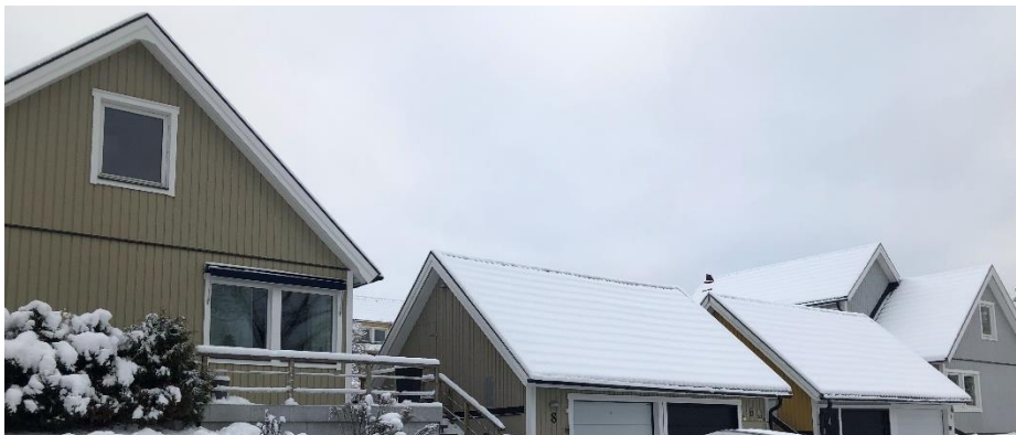
Figur 5: Byggnader i närheten av Husmodern 6.
